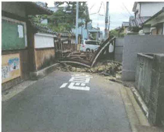
大阪地震の被害
