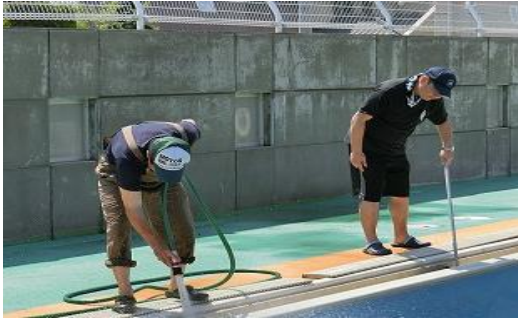
プール周りの細い溝も高圧洗浄機で！
