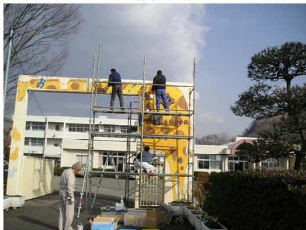
当日の作業風景
