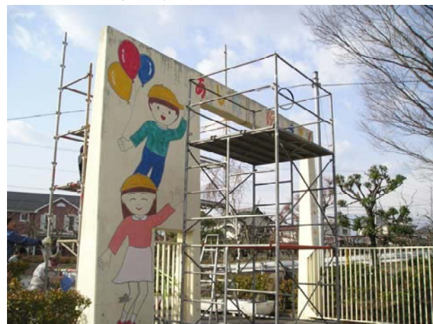
足場が組み立てられました
