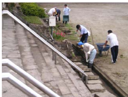
側溝の泥上げ作業
